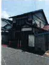
リノベ前の外観
