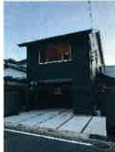
リノベ後の外観
