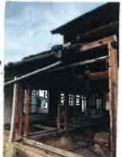
内部解体中の様子
