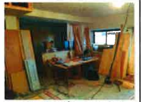
工事中の室内の様子
